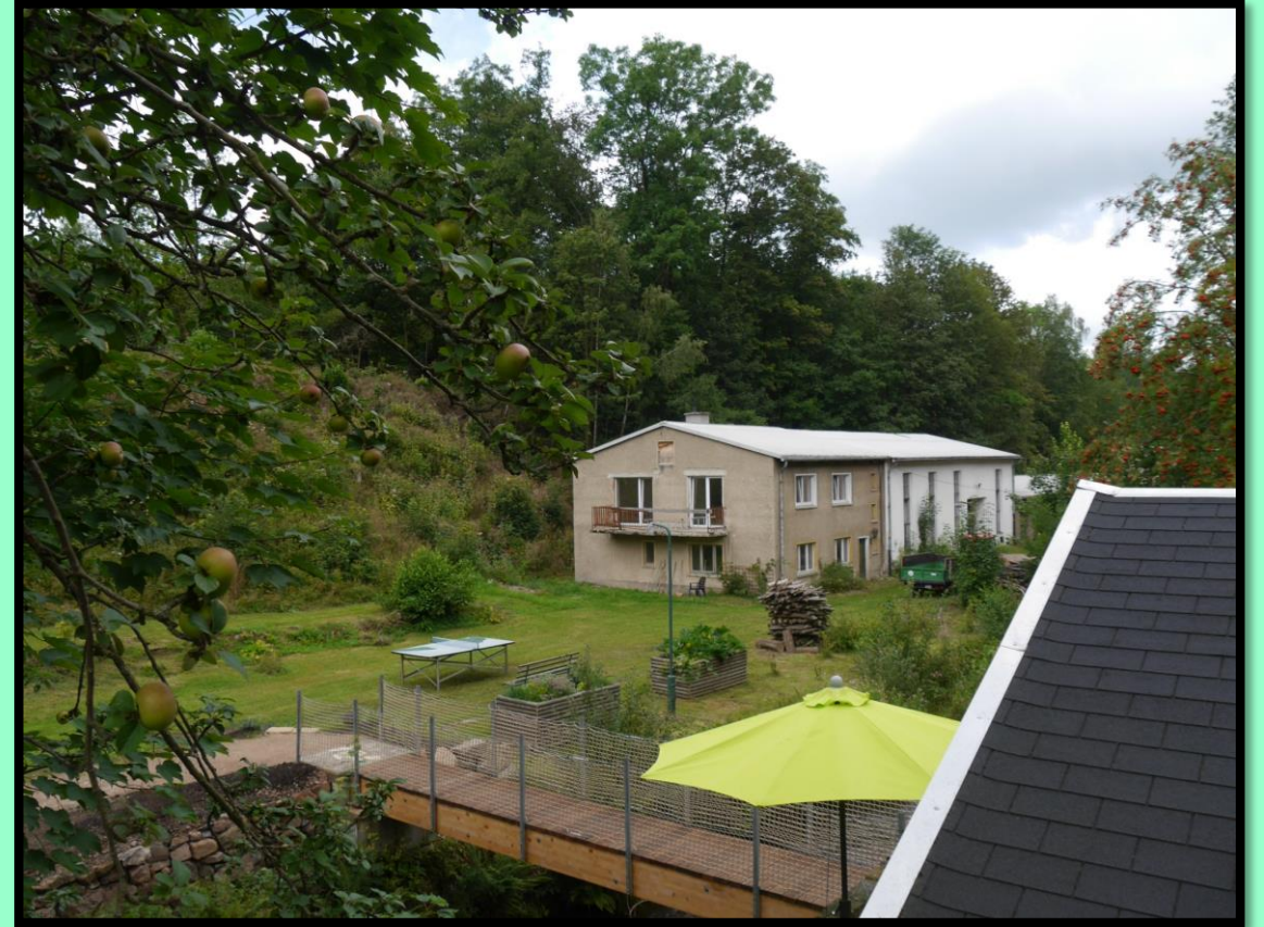
Nachbargrundstück talabwärts des ehemaligen Schotterwerkes. Bis Kriegsende 1945 befand sich dort eine Schmiermittelfabrik für pflanzliche Öle und Fette,
