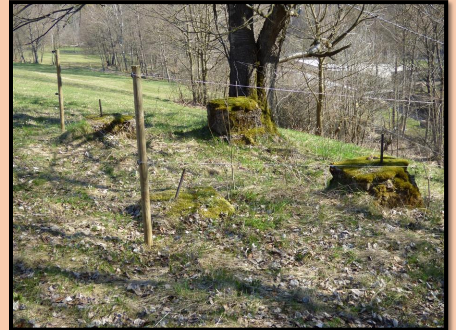
Fundamentreste der Seilbahnstützen
