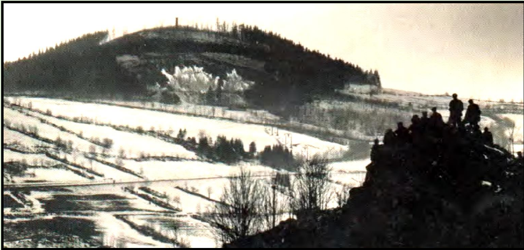
Blick auf die Großsprengung am 1. März 1930
