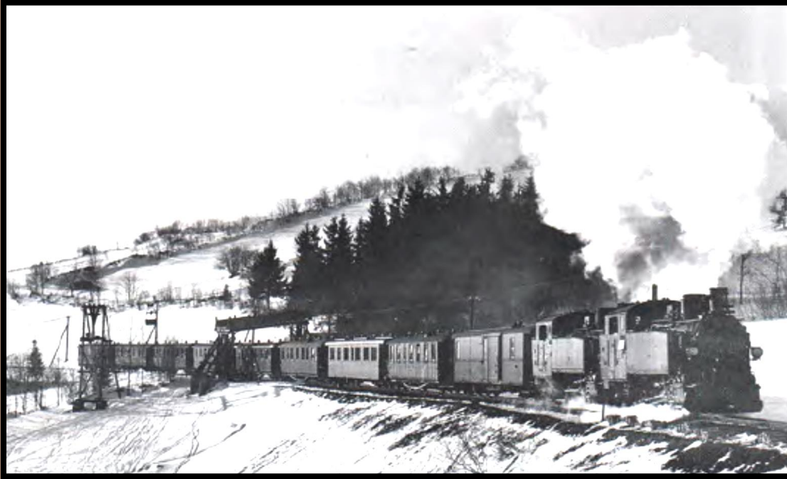
Die hölzerne Brücke unter der Steinbruch-Seilbahn wurde zum Schutz der Schmalspurbahn Züge vor herabfallenden Steinen errichtet Foto: Walter Hahn. um 1930. Quelle: Deutsche Fotothek - SLUB Dresden
