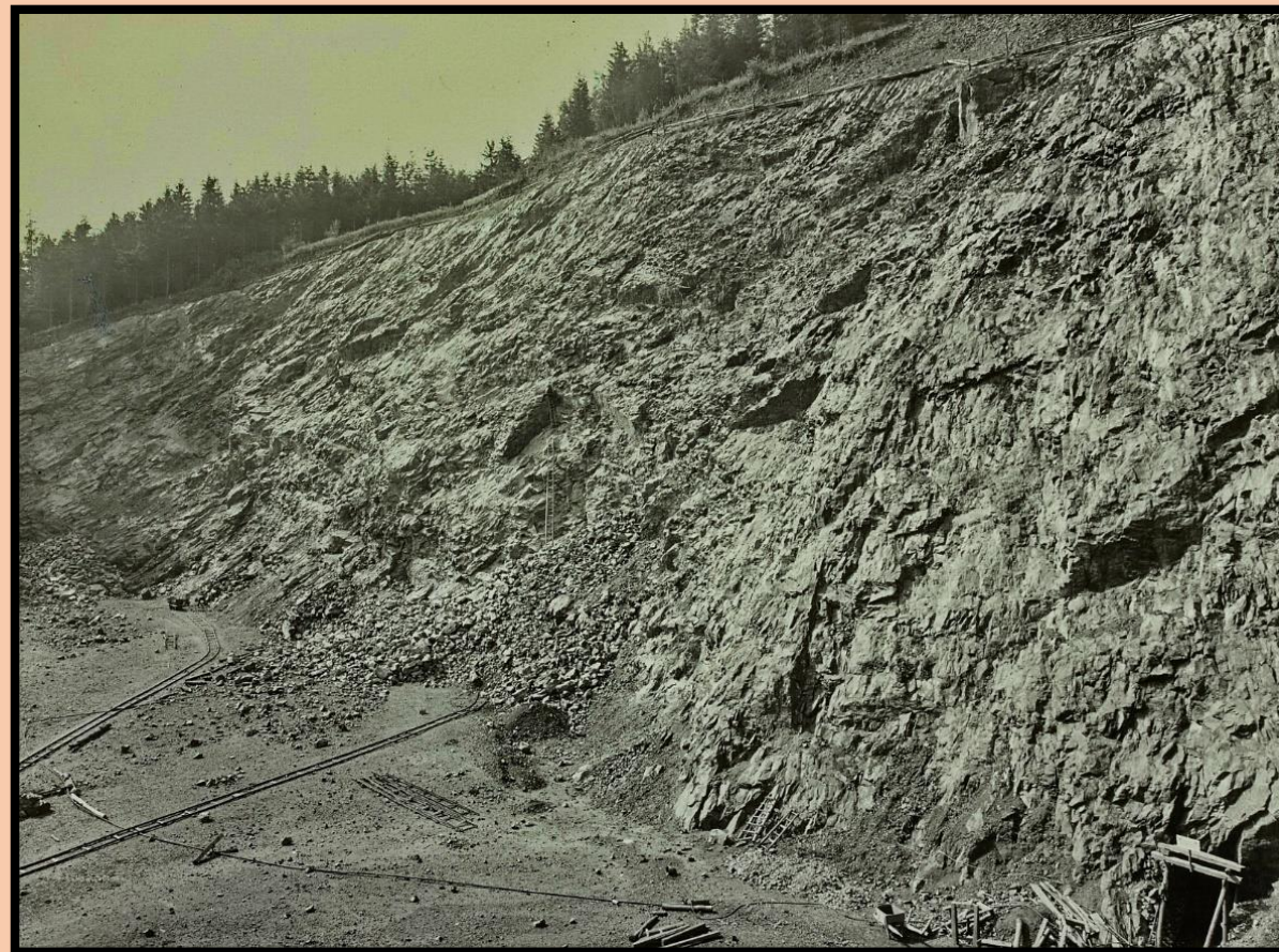
Gleise zum Abtransport der Bruchmasse, rechts Stollen zur Auffahrung der Kammern für die Großsprengung,
