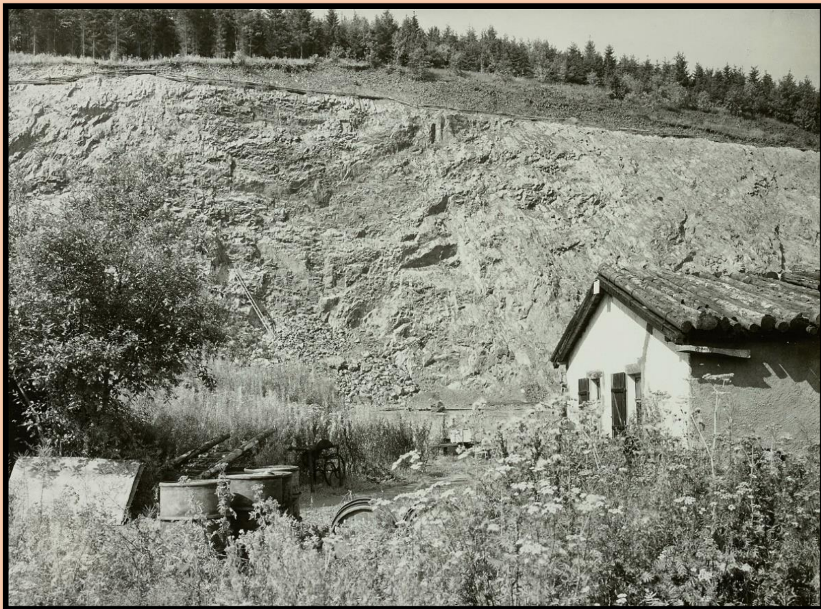
Blick zur Bruchwand, anfangs wurden die Gewinnungs- und Sprengarbeiten über Leitern an der Wand ausgeführt,
